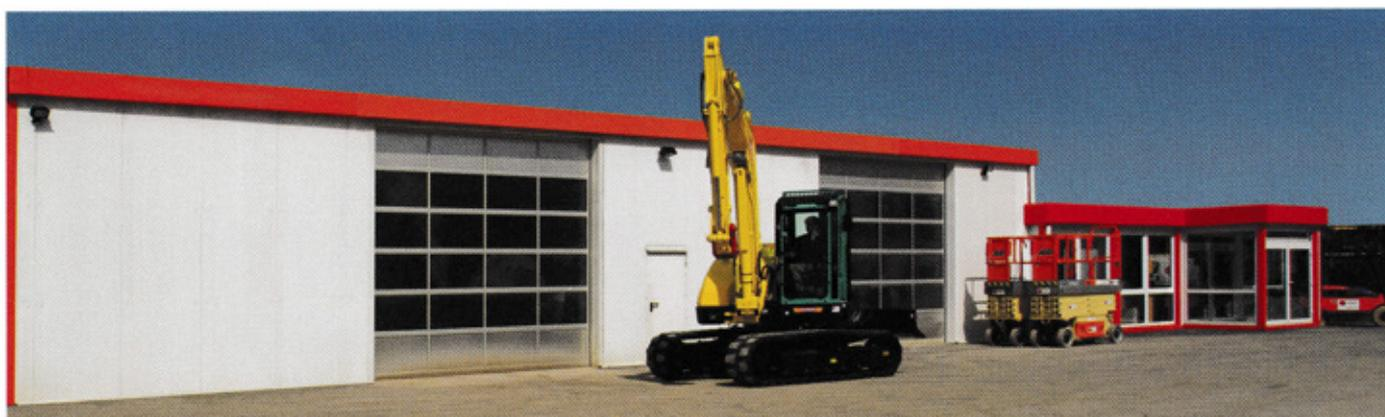
Die TRANSFEREXPRESS kann mit den für den jeweiligen Einsatzzweck erforderlichen Türen, Toren und Fenstern ausgestattet werden. Mit einer stützenfreien Breite bis zu 18 m und Traufhöhen bis zu 7,5 m ist die Halle ausreichend dimensioniert, um für die Mehrzahl der Aufgaben in Industrie, Handwerk und Handel geeignet zu sein.
